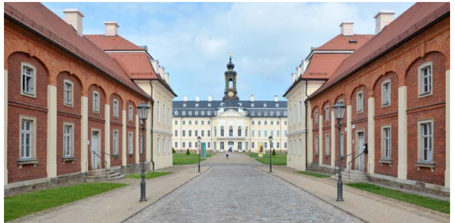
Die äußere Hülle des Schlosses Hubertusburg in Wernsdorf ist weitestgehend saniert und lässt ahnen, wie das Bauwerk die einreitenden Gäste einst beeindruckte.
